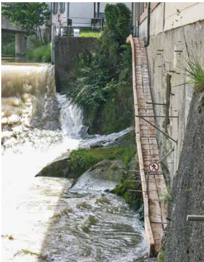
Biberrampen sind meist einfache Holzstege, auf welchen die Tiere das Hindernis überwinden können. Foto: Philip Taxböck, Hallo Biber! Ostschweiz
